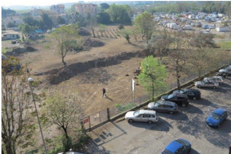
L'area nel 2013, con i lavori in corso
