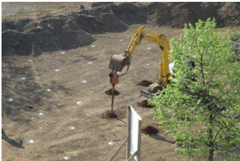
Si nota anche il cartello del cantiere
